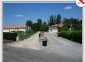
Accès trop larges
