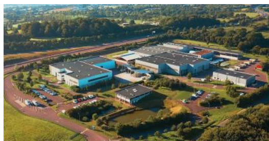
Pôle de valorisation de Cavigny - 2021
