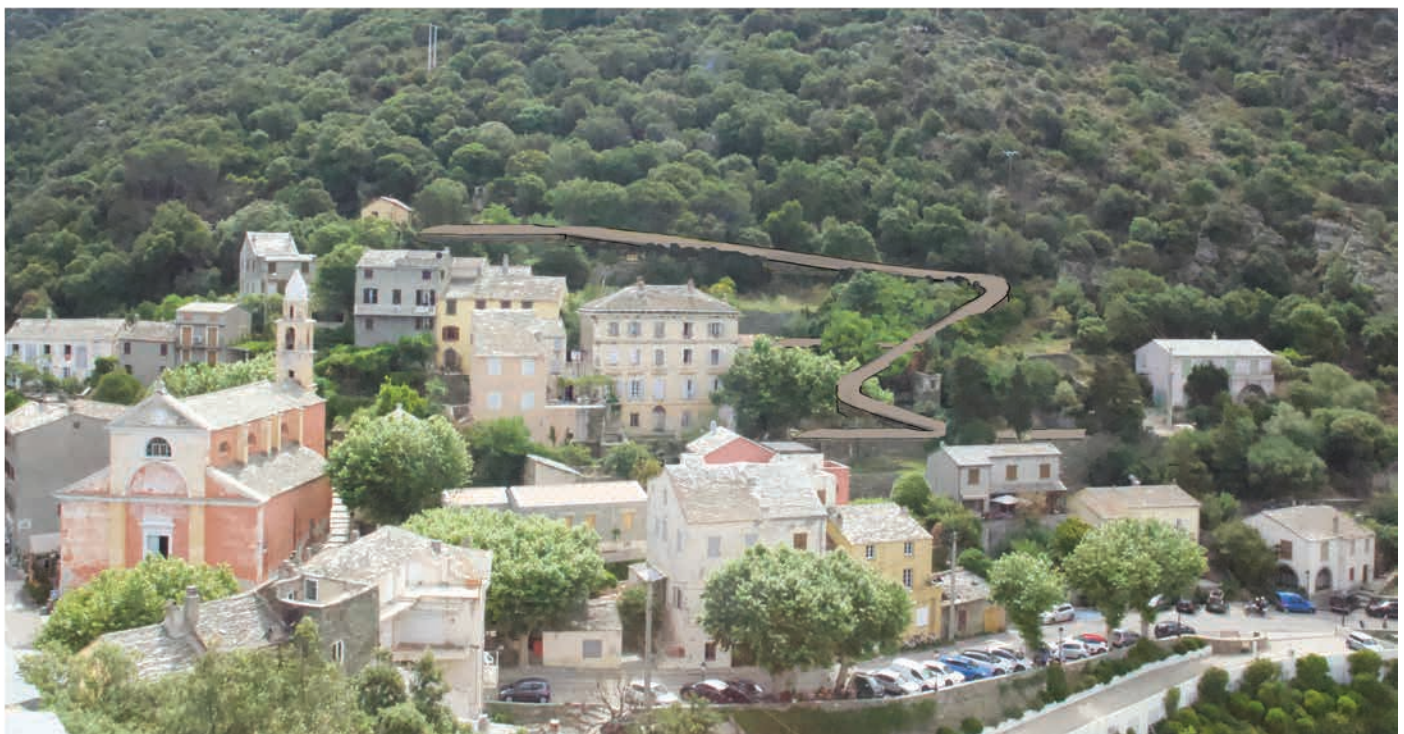
Un réseau de desserte qui s'appuie sur les anciennes terrasses
