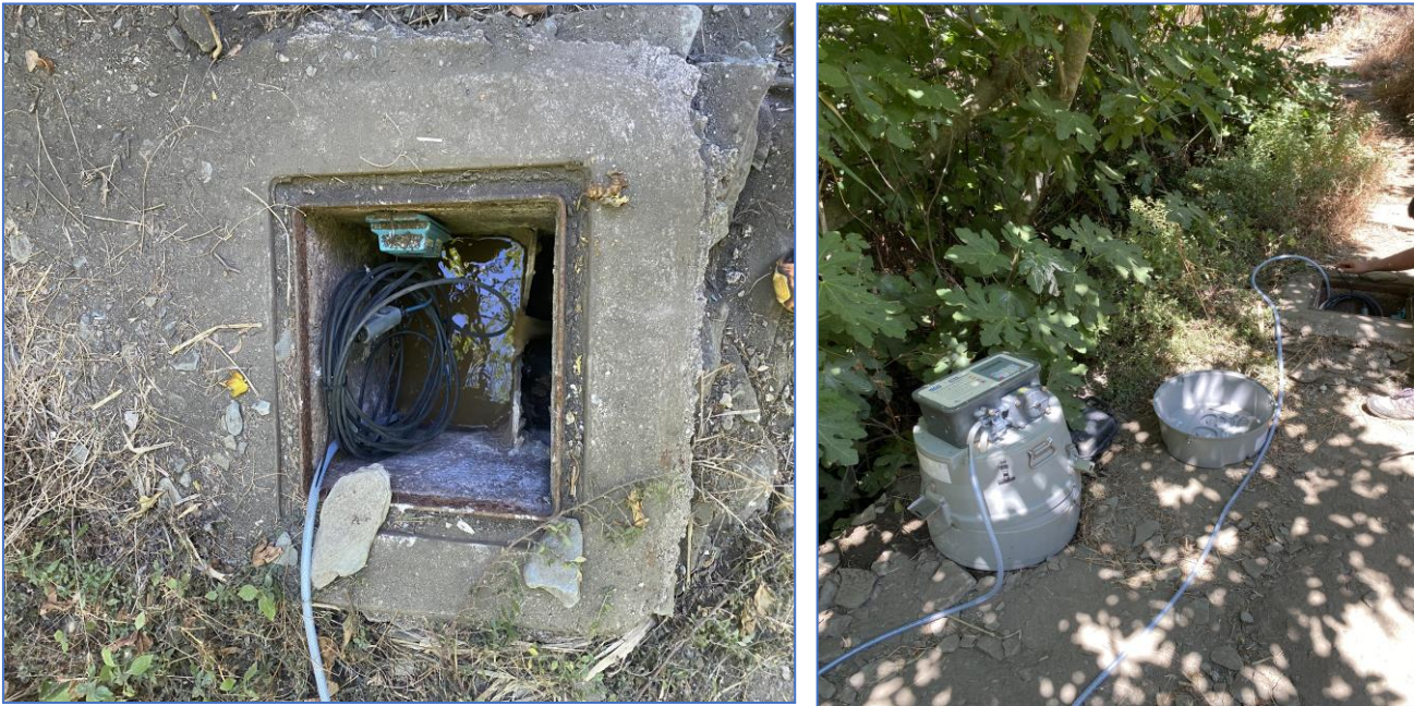
Photographies 2 : Exemples des points de mesures hydrauliques (à gauche) et de pollutions (à droite)
