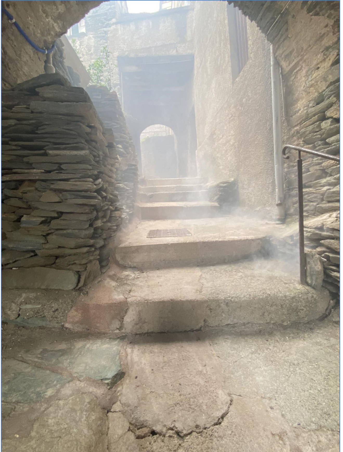
Photographie 3 : Réalisation des tests à la fumée au centre du village de Nonza (anomalies D6 et D7 : Casses, porosité des réseaux, problèmes d'étanchéité)
