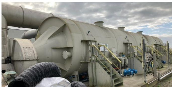
Tour de lavage verticale et ligne de caissons de lavage horizontal Source : TC INNOV
