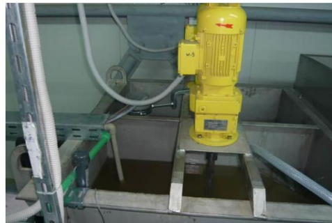
Cuves coagulation/floculation avec agitateurs
