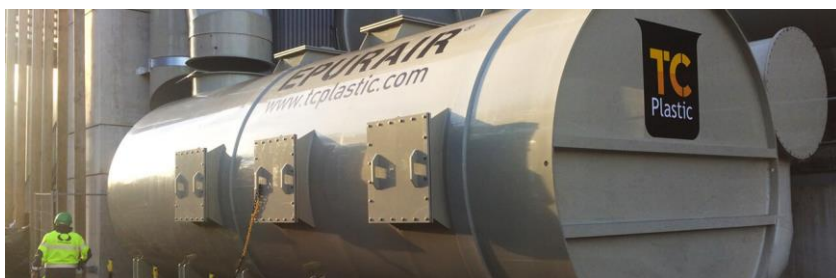
Système de traitement par adsorption sur charbon actif : à gauche, horizontal et fixe, à droite : “mobile” et vertical Source : Jacobi
