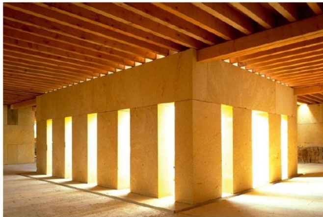
Exemple d'association de pierres du Pont du Gard et de structure poutre bois – Chai viticole Vauvert – architecte Gilles Perraudin
