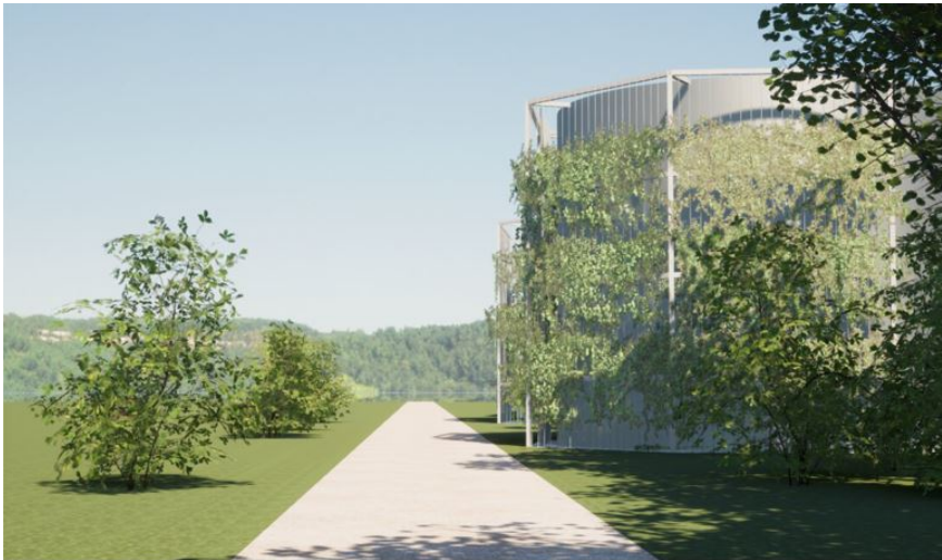
Habillage des cuves de réserve d'eau par des treilles végétalisées.
