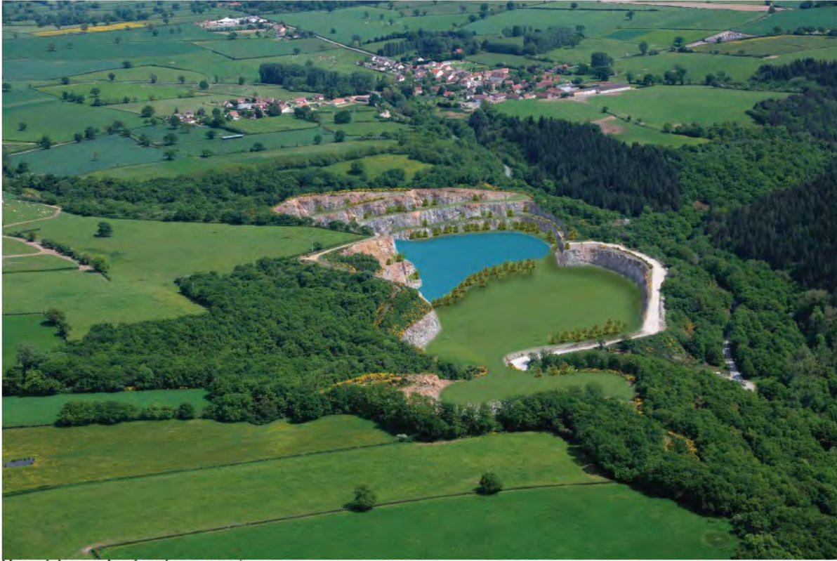
Vue aérienne du réaménagement
