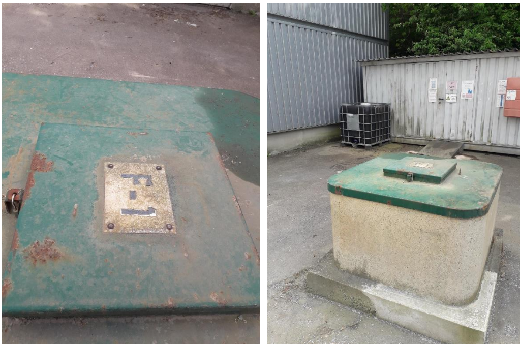
Figure 1. Protection de la tête de forage actuel du site de Taden
