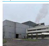
Installée aux Landes Basses à Taden, l'usine de valorisation énergétique va être exploitée d'ici quelques jours par la société Suez.
