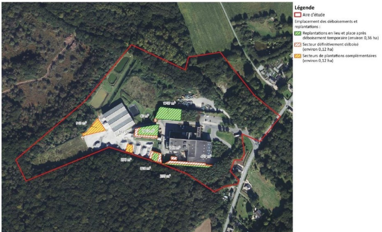
Figure 3: Déboisements et replantations à la fin du chantier (source : étude d'impact)
