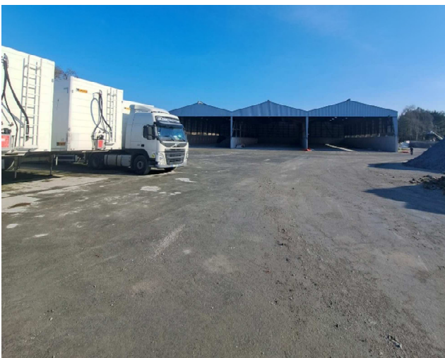
Entrepôt de stockage des mâchefers, et zone de stationnement poids lourds.
