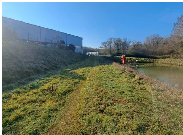
Lagunes de réception des eaux de traitements.
