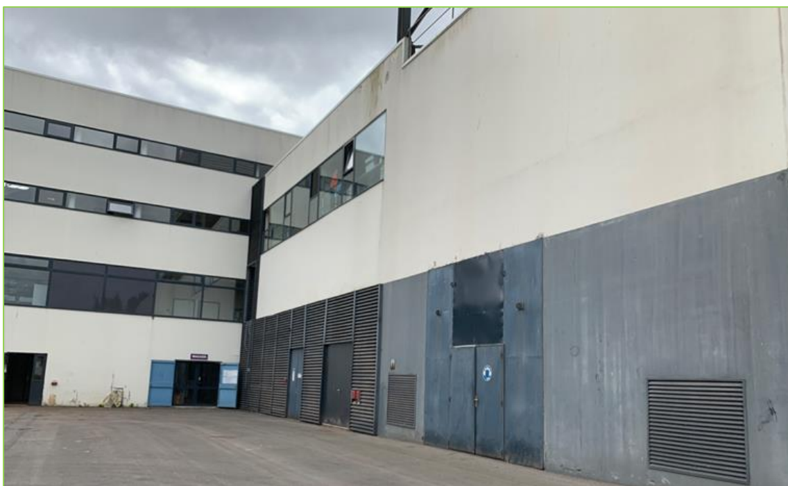
Traitement des locaux techniques
