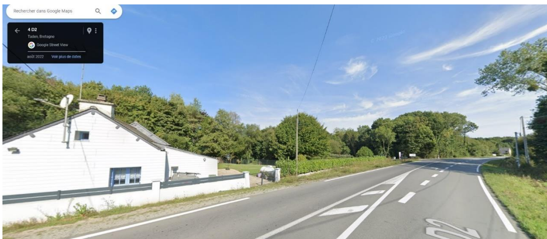
PC8b – PHOTO DU TERRAIN DANS SON ENVIRONNEMENT LOINTAIN VUE SUD-EST DEPUIS LA D2
