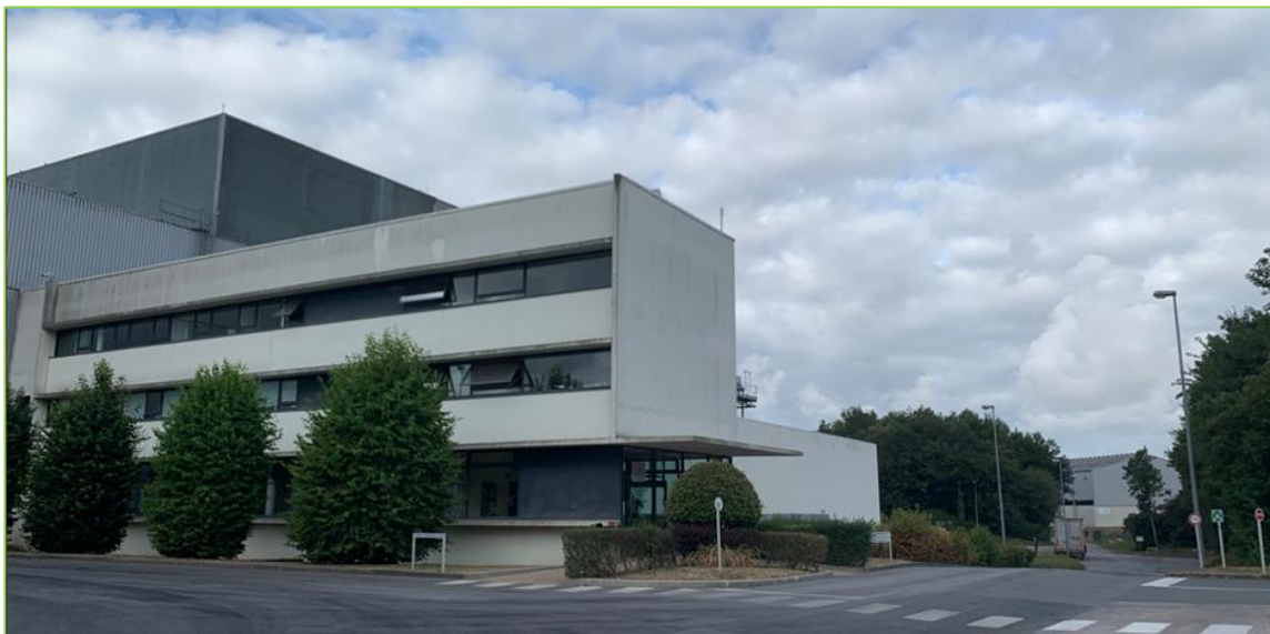
Traitement du bâtiment des locaux administratifs, sociaux et pédagogique existants
