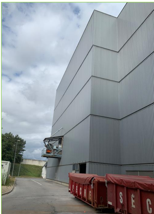
Traitement des bardages existants
