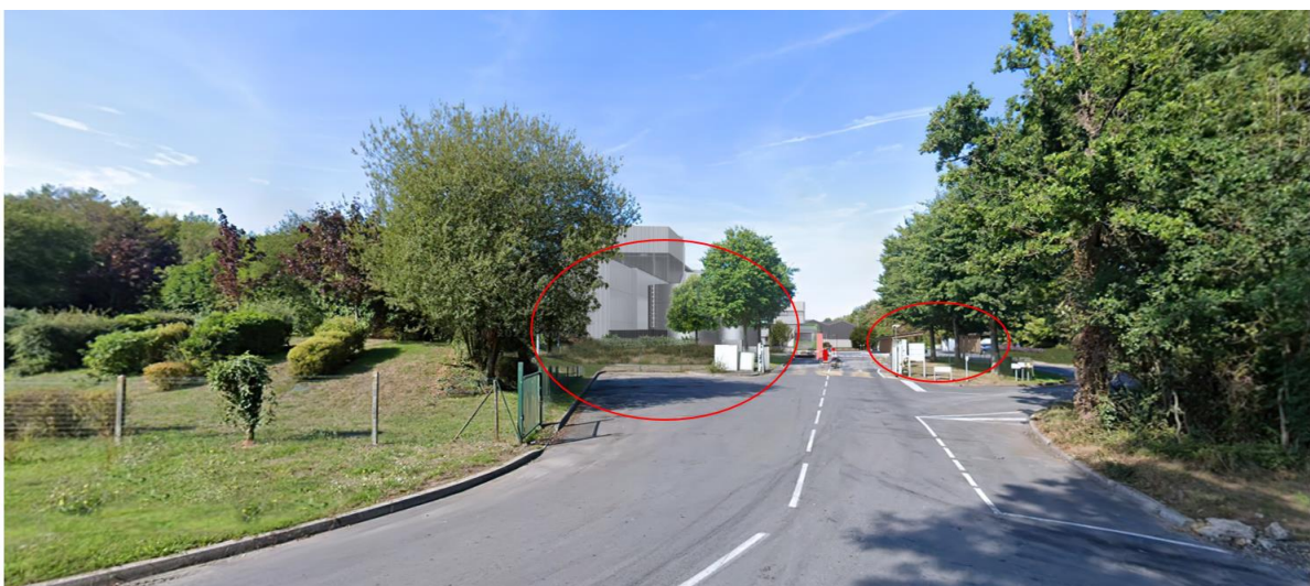
PC6c – INSERTION DU PROJET DANS SON ENVIRONNEMENT VUE DEPUIS L'ENTREE DU SITE
