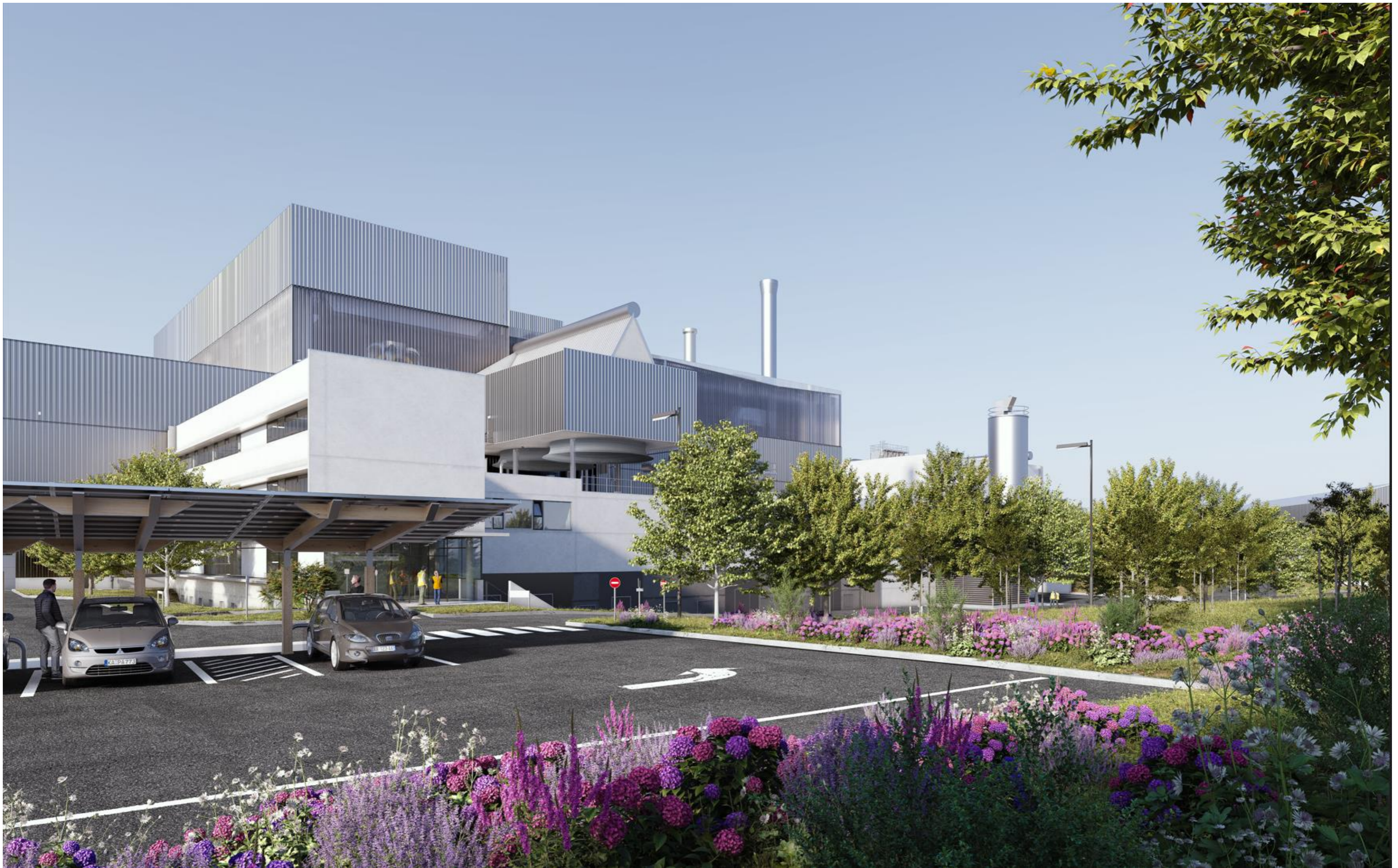
VUE LIBRE – VUE DEPUIS LE PARKING DE L'UVE
