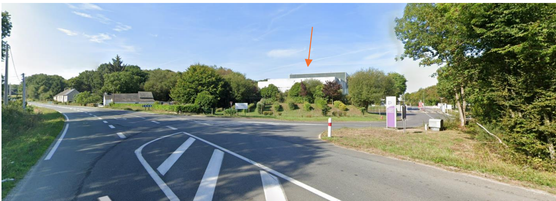
Figure 7 : Vue depuis l'entrée du site de l'UVE de Taden
