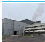
Installée aux Landes Basses à Taden, l'usine de valorisation énergétique va être exploitée d'ici quelques jours par la société Suez. (Photo: Ouest-France)
