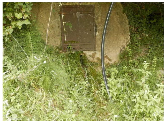
Photo 24 : Source captée en pied de versant au droit de la Montée du Pillard.
