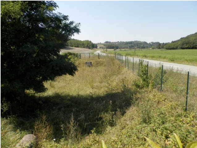
Photo 3: Bassin écreteur de crue du ruisseau du Bivet.
