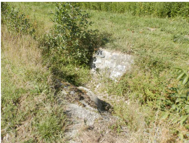
Photo 5: Enrochement réalisé face à la sortie du franchissement routier de la RD124 afin de limiter l'érosion localisée du lit mineur du Bivet.
