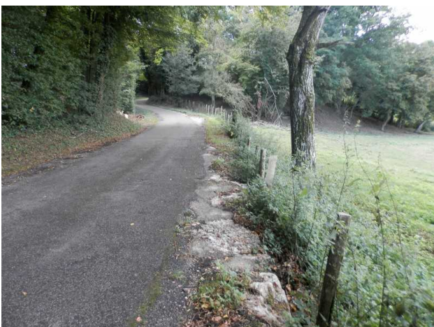
Photo 23 : Enrochement réalisé en bordure du chemin du Bivet afin d'en limiter l'érosion.
