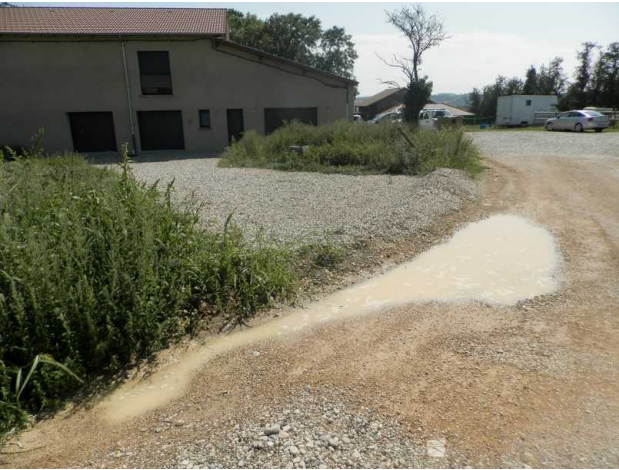
Photo 19 : Propriété située au lieu-dit Le Valentier impactée par le phénomène de ruissellement en provenance d'un chemin. Une levée en gravillons a été réalisée.
