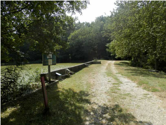
Photo 1: Les berges des étangs situées en partie amont du cours d'eau sur le territoire ont été renforcées.
