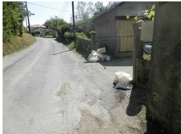
Photo 18 : Zone de ruissellement en provenance de terrain agricole pouvant impacter des propriétés au droit de la route de Ponas.
