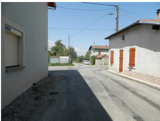
Photo 9 : Cuvette réceptacle des eaux de ruissellement au carrefour entre la RD75 et la route de Ponas.
