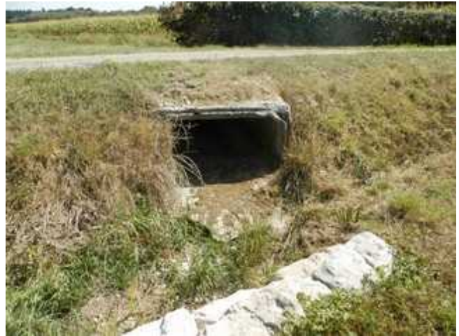
Photo 4: Enrochement réalisé face au dalot de franchissement du chemin des Allouets.
