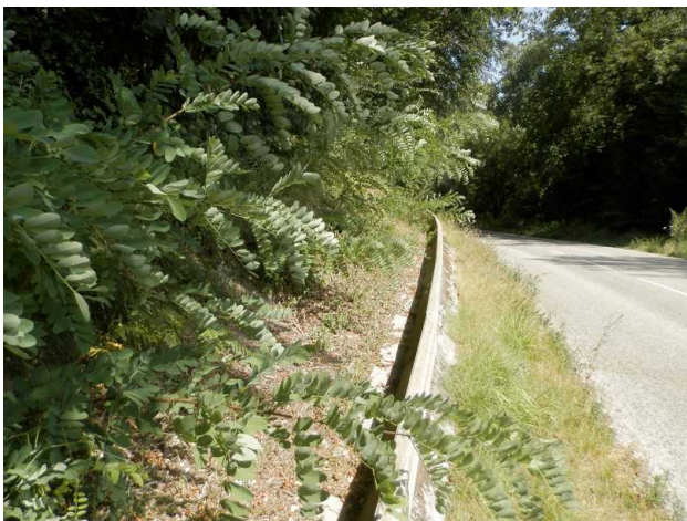
Photo 21 : Cunette en béton réalisée au droit de la RD124 dans l'optique de limiter la propagation du ruissellement vers la chaussée.
