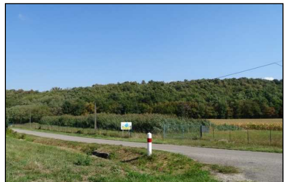
Station d'épuration "Ros'eaupure" des Allouets
