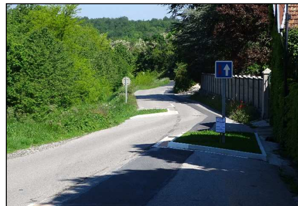
Aménagement de sécurité (alternat) sur la route des étangs
