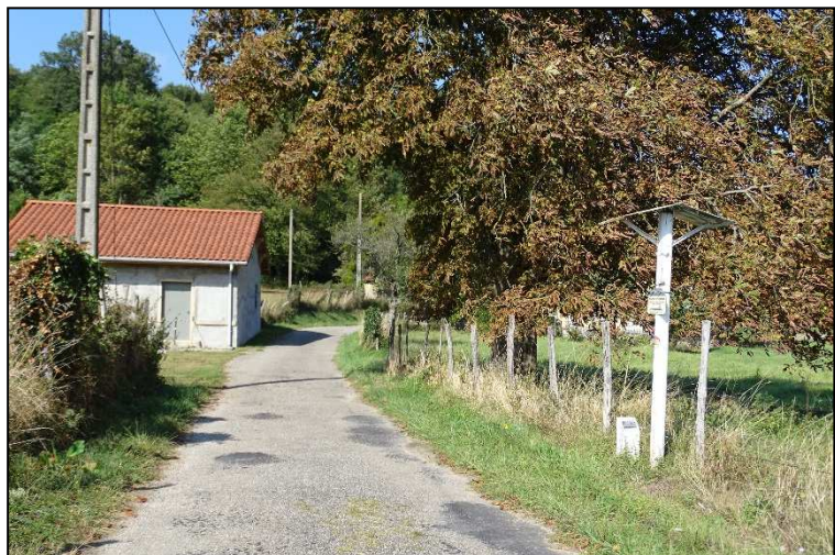
Conduite d'hydrocarbures - Les Sétives
