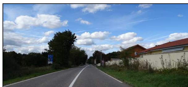
Route de Vienne (RD 36) à Beausoleil
