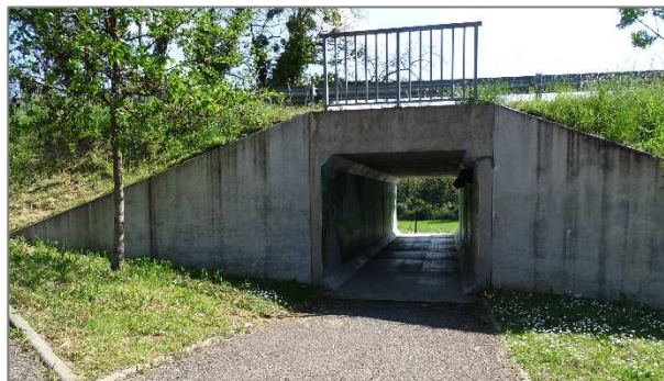
Passage sécurisé sous la RD 36 (avril 2022)
