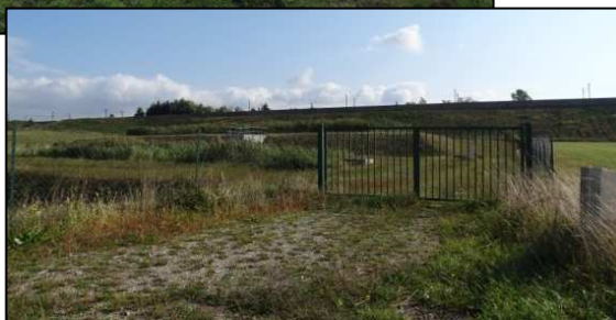
Station d'épuration - Chemin des Pires
