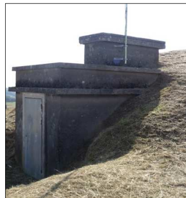
Réservoir de Ponas Les Cruis
