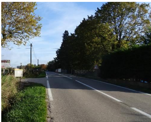
RD 75 au droit du centre équestre
