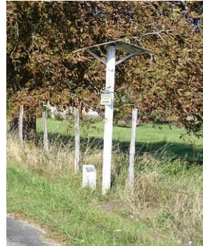
Conduite d'hydrocarbures aux Sétives
