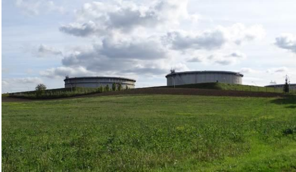
Stockage de Saint-Quentin-Fallavier
