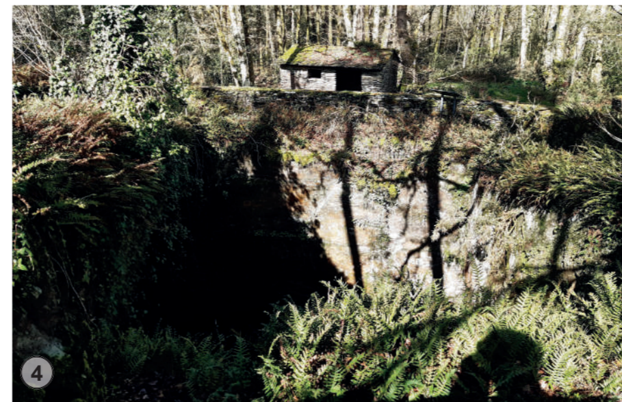
Le puit en face de la cabane est très profond, clôturer par un muret, il réserve un risque de chute sur son flan ouest, la suppression du chemin ouest permettra de sécuriser ce site tout en assurant la découverte de la cavité.
