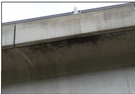
Pont dans lequel se trouve la colonie de Pipistrelle pygmée et détail de l'entrée du gîte
