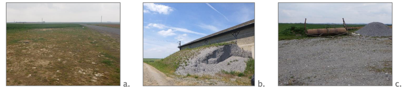
Figure 24 : Zones de dépôts temporaires situées à moins de 200 mètres des éoliennes
