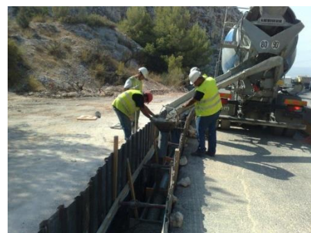
Coulage du béton (Source RTE)
