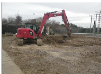
Travaux de terrassement (Crédit RTE)
