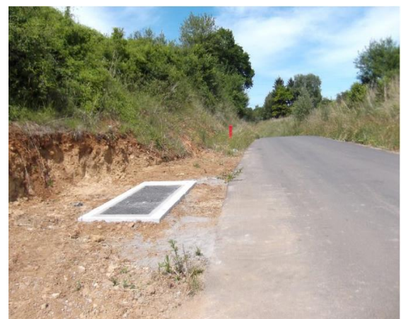
Un puit de terre (Source RTE)
