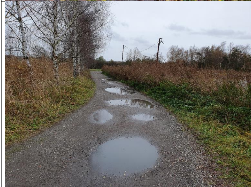
4 : Chemin stabilisé avant le rejet dans la Sarre
