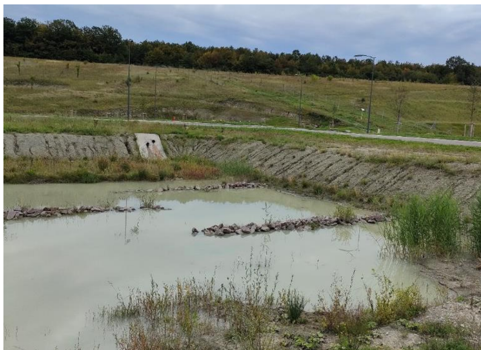
Bassin de gestion des eaux pluviales
