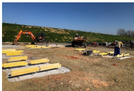
Fondations de cellules HT (Crédit RTE)
