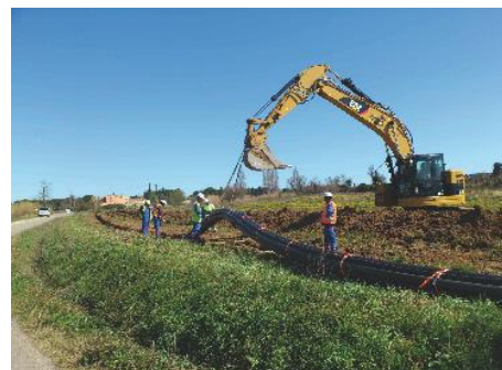
Pose de fourreaux PEHD en pleine terre (Source RTE)
