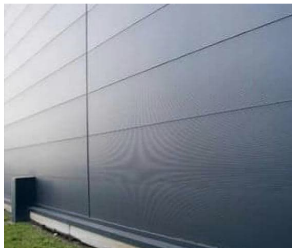
Bardage type Kingsplan, finition métallisée – RAL 7037
