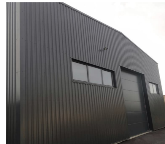
Mur rideau – Surface vitré + panneaux sandwich / métallique laqué + serrurerie aluminium RAL 7037
