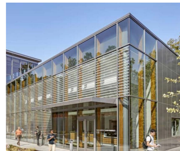
Mur rideau – Surface vitré + panneaux sandwich / métallique laqué + serrurerie aluminium RAL 7037
