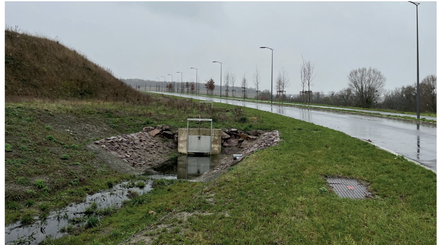
Vue 3 sur les alignements d'arbres réalisés dans le prolongement de la rue André-Marie Ampere
