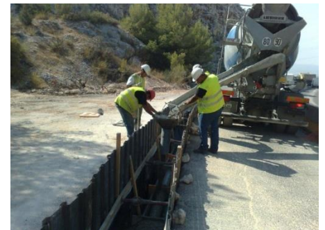
Coulage du béton (Source RTE)
