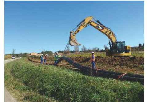
Pose de fourreaux PEHD en pleine terre (Source RTE)
