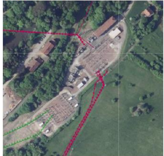
Vue aérienne du poste électrique de Sarreguemines
