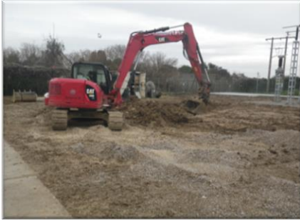
Travaux de terrassement (Crédit RTE)
