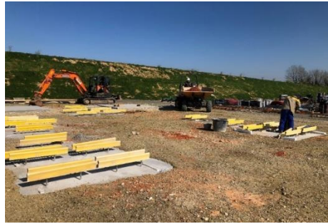
Fondations de cellules HT (Crédit RTE)
