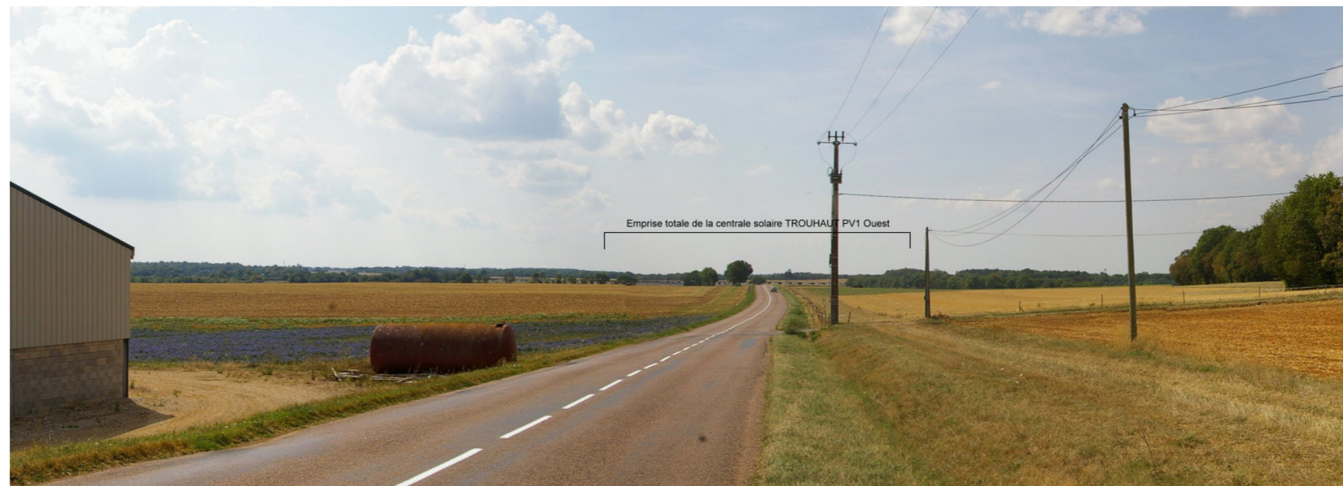
Vue 2: Vue de l'ensemble de la centrale solaire TROUHAUT PV1 Ouest depuis la départementale n°16 au Nord du projet.
