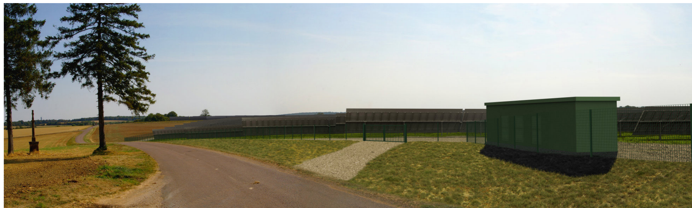
Vue 1: Vue de l'entrée secondaire du projet à l'Ouest de la centrale solaire depuis la départemental n°7 (sans la haie).
