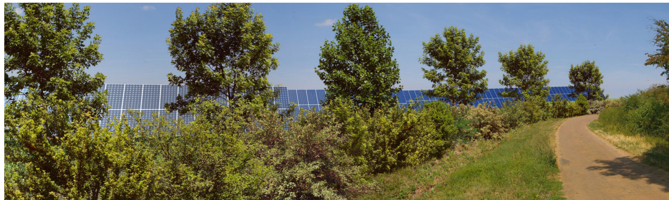
Vue 1: Vue depuis la voie communale n°5 à l'Est de la centrale solaire (avec la haie).
