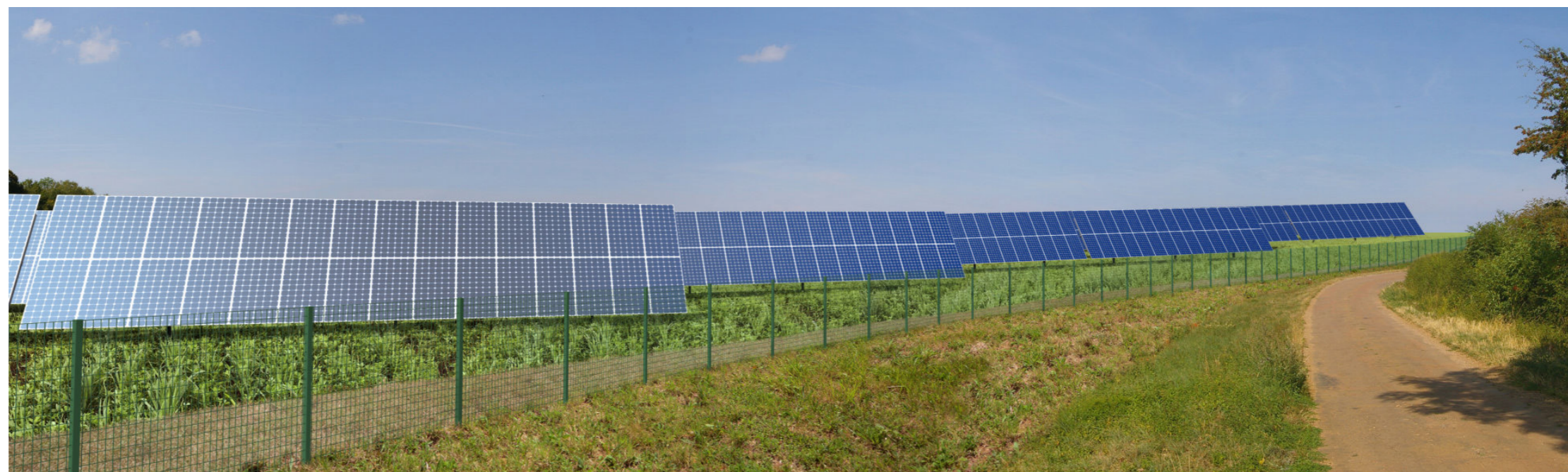
Vue 1: Vue depuis la voie communale n°5 à l'Est de la centrale solaire (sans la haie).
