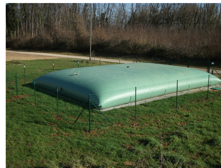
Citerne à eau 30m 3 pour les services incendie
