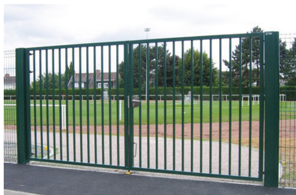
Portail d'accès au site
