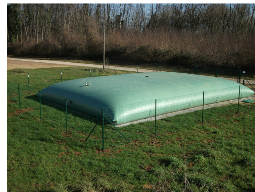
Citerne à eau 30m 3 pour les services incendie
