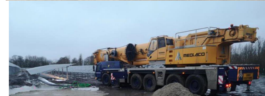
Livraison du Poste de transformation (TSE)
