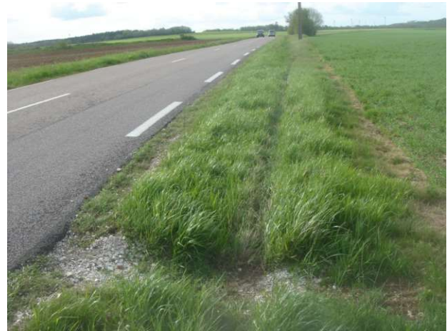
RD 16, accotement en bordure ouest de PV2
