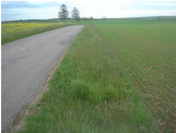
RD 7, accotement en bordure nord de PV1
