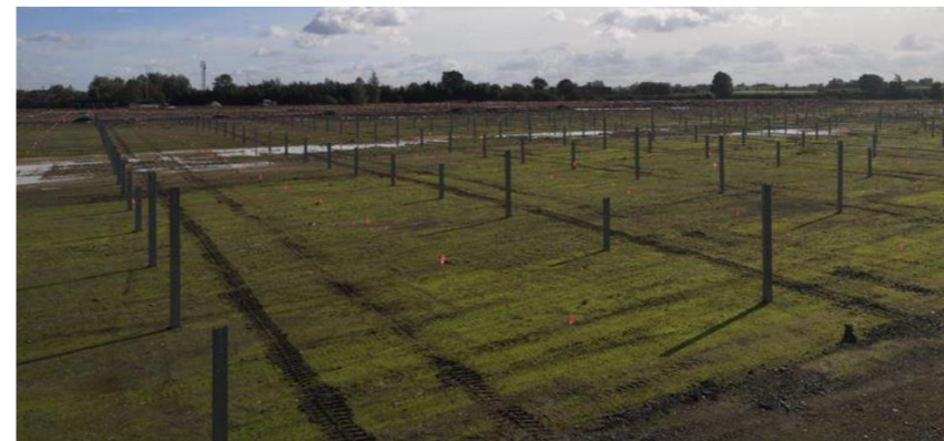
Passage unique d'engin à l'avancement pour battage
