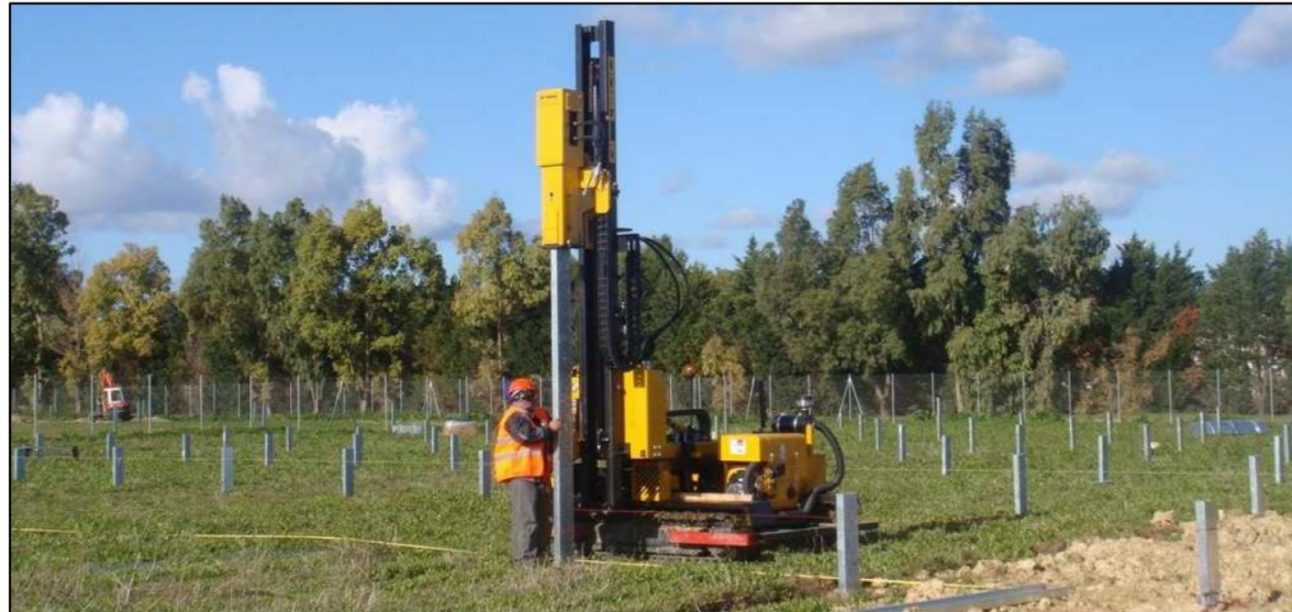
Sonnette de battage hydraulique
