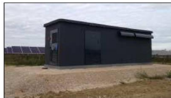
Exemple de poste de transformation béton
