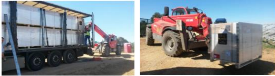
Livraison des panneaux photovoltaïques (source SPIE)
