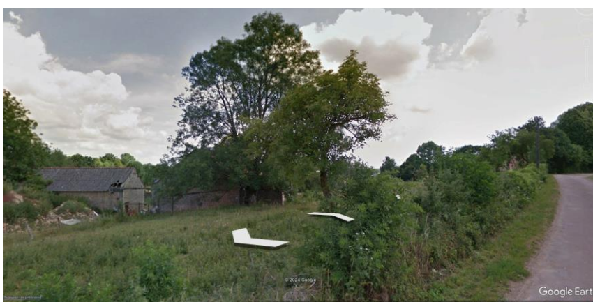
Point de vue n°3 en direction des bâtiments des parcelles cadastrales C5 de Trouhaut situés en face du projet
