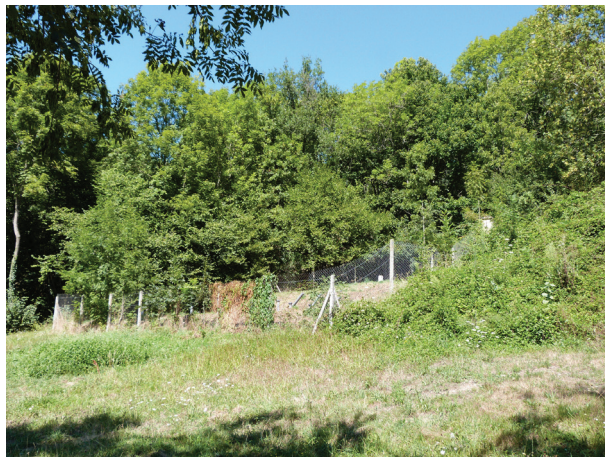
25. Cazenave-Allens / station d'épuration
