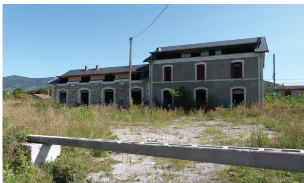
31. Saint-Paul-de-Jarrat / bâtiment désaffecté
