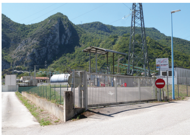
410. Tarascon-sur-Ariège / centrale électrique
