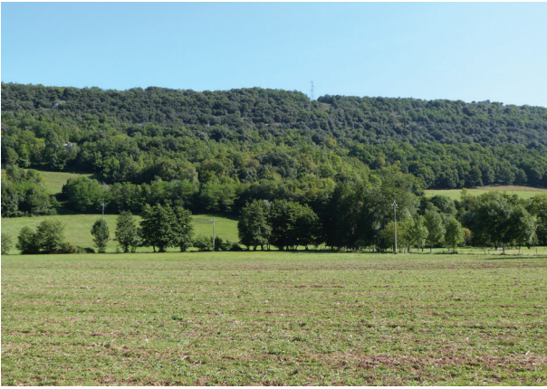
52. L'Herm / pylone sur la crête de la Quière
