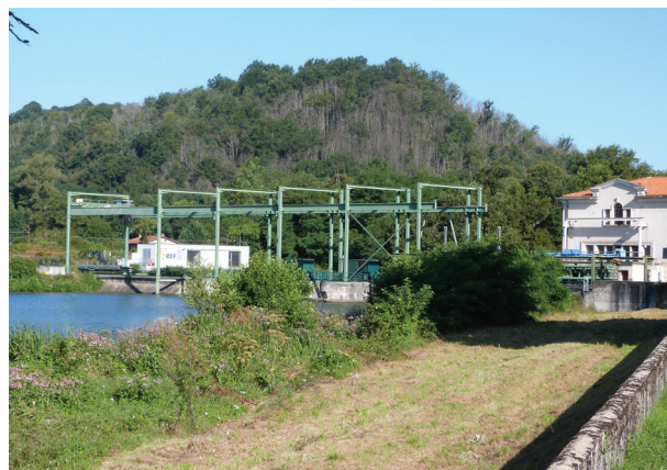
51. Foix / barrage hydroélectrique de Labarre
