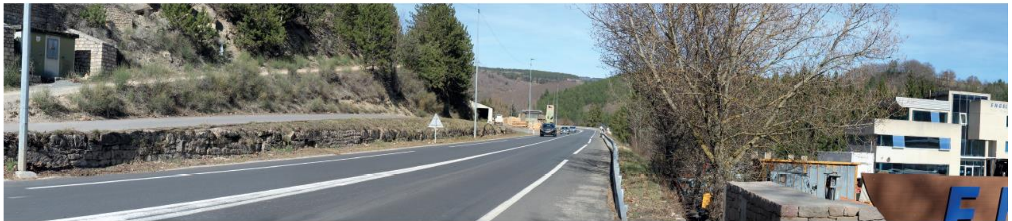
► Vue depuis la route N88 - Etat projeté - Champ visuel de la prise de vue 90°
