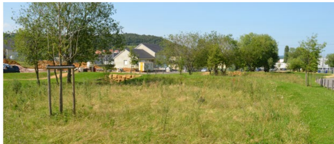
Bassin de rétention végétalisée (crédit photo EGIS)
