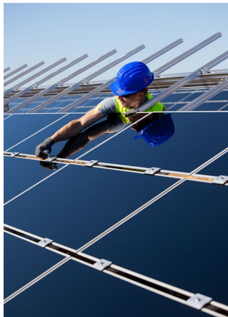
Remplacement de module (crédit photo EDF Renewables)
