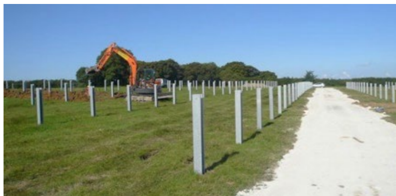
Travaux de montage des supports des modules (crédit photo : EDF Renewables)
