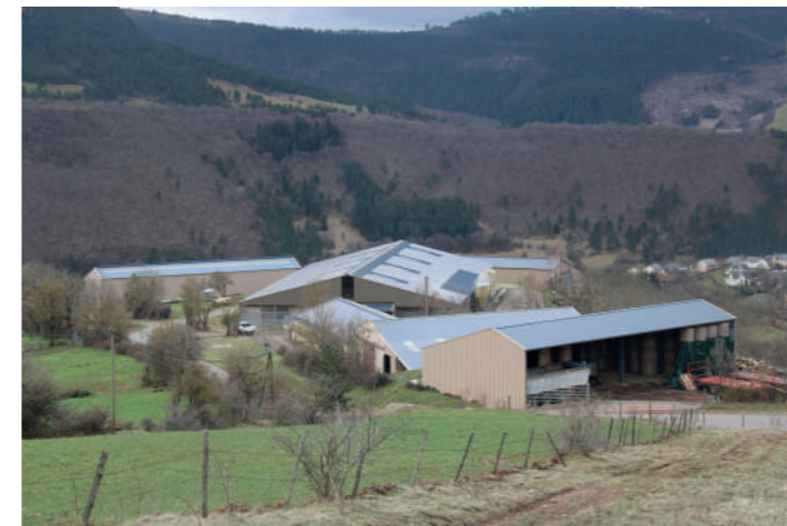
Photo n° 51 : Les panneaux photovoltaïques sur toiture de Berbogal
