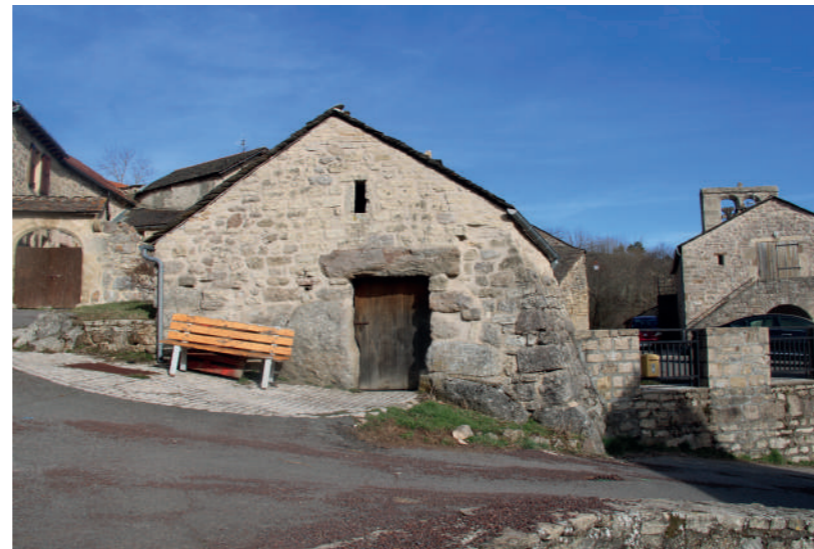
Photo n° 34 : Le four à pain de la Rouvière
