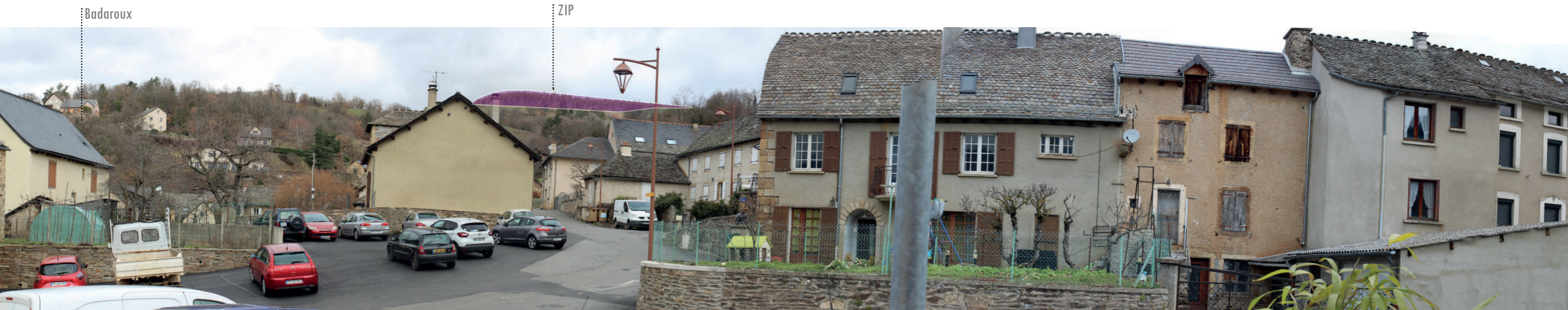
► Vue depuis le village de Badaroux au niveau de la mairie
