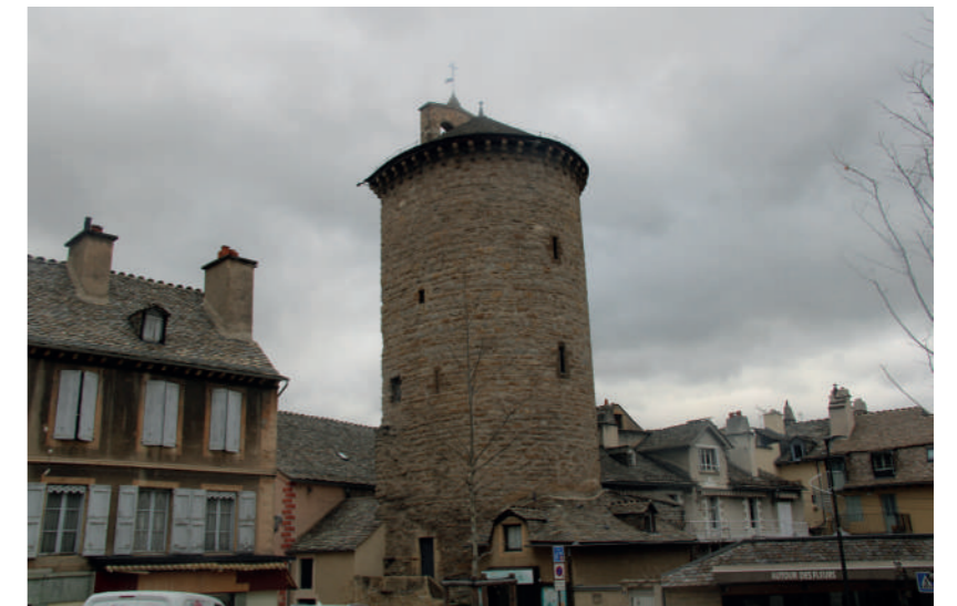
Photo n° 23 : La tour des Pénitents à Mende
