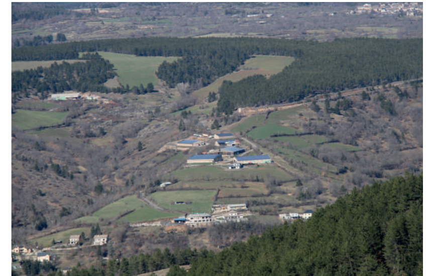
Photo n° 6 : Les panneaux photovoltaïques sur toitures
