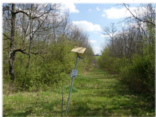
Tranchée en milieu forestier sur le tracé de la canalisation
