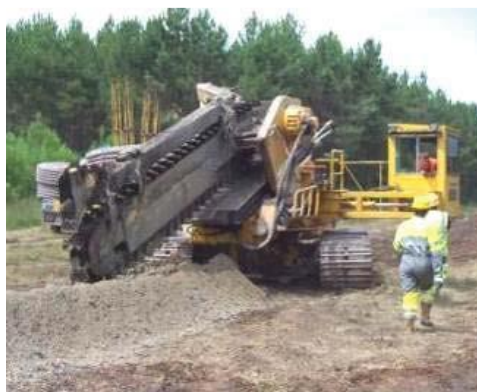
Figure 14 : Intervention d'une trancheuse pour la mise en place d'un drain temporaire le long de la tranchée
