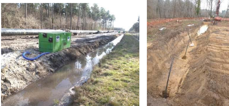
Figure 13 : Exemples de rabattement de nappe avec aiguilles filtrantes
