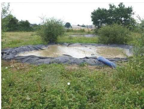
Figure 174 : Bassin de décantation pour les eaux turbides issues d'une niche de forage
