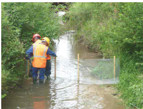
Figure 168 : Mise en place de barrières en amont et aval de l'emprise des travaux empêchant le passage des poissons
