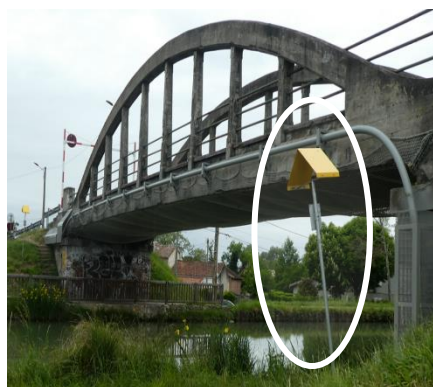
Figure 55 Bornes et balises indiquant la présence de la canalisation enterrée – exemples
