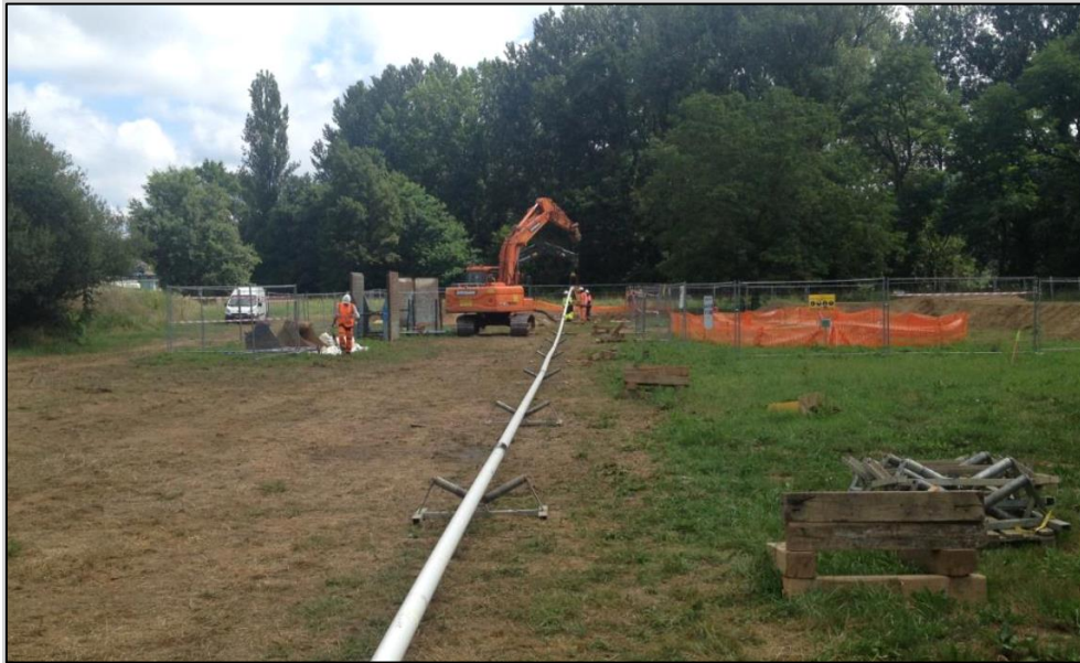
Figure 195. Exemple de fausse piste avec la pièce préfabriquée disposée sur des rouleaux avec galets en néoprène (Photo : TEREGA)
