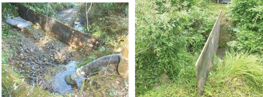
Figure 165 : Exemple de pose de plaques métalliques enfoncées dans le lit mineur et dans les berges
