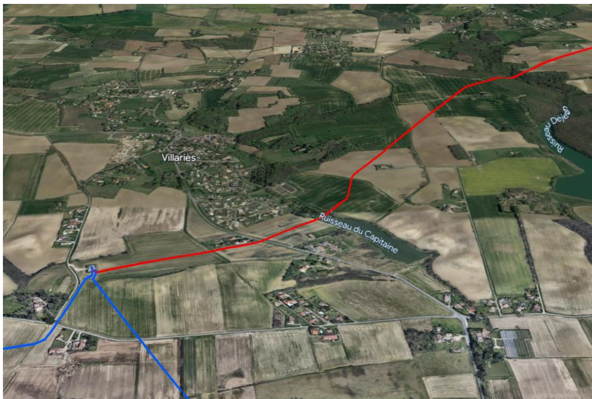
Figure 13. Départ de la canalisation au départ de Villariès
