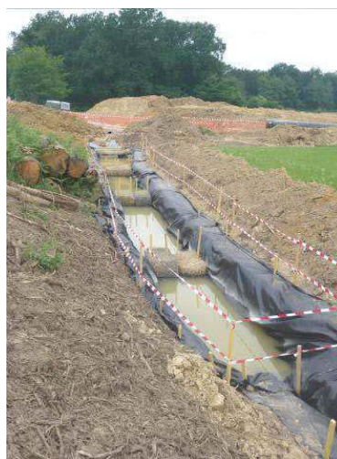
Figure 179 : Exemple de fossé subhorizontal favorisant la décantation
