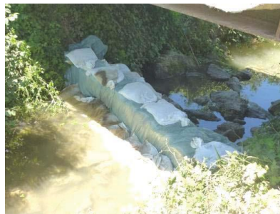
Figure 167 : Batardeaux constitués de sacs de sables enroulés dans une bâche
