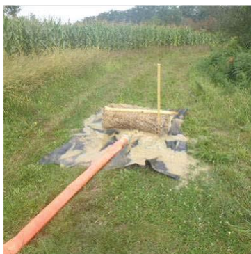
Figure 172 : Epannage sur prairie, le point de rejet est aménagé avec du géotextile et un caisson de paille
