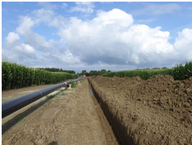
Figure 49 Construction de la canalisation (sur cales) et ouverture de la tranchée avec tri des terres végétales et profondes
