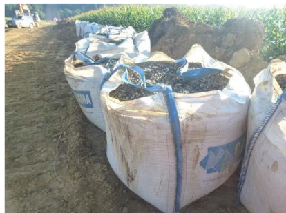
Figure 166 : Big-bags remplis de graviers insensibles à l'eau
