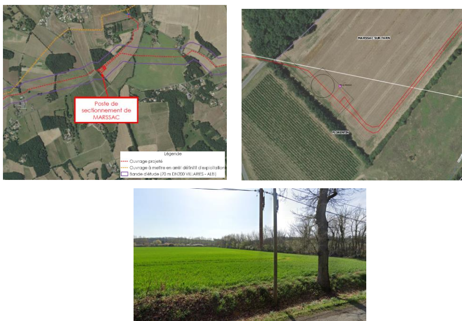
Figure 112 : Localisation du poste de sectionnement de Marssac par rapport à la canalisation projetée (images au-dessus) et vue de son futur emplacement (image en-dessous)
