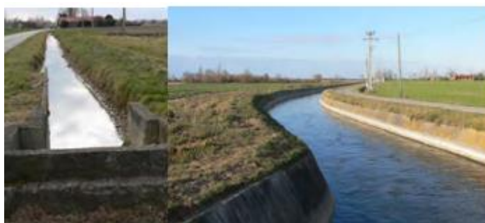
Figure 97 : Richesse du réseau hydraulique
