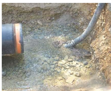
Figure 171 : Exemple de pompe enfouie dans les graviers en fond de fouille ou posée dans une structure métallique entourée de galets afin de diminuer le pompage de MES à la source
