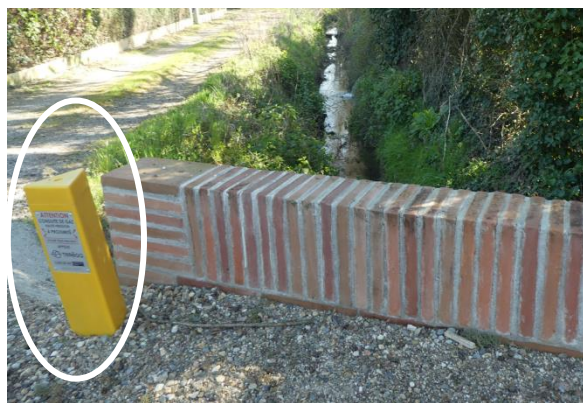
Figure 55 Bornes et balises indiquant la présence de la canalisation enterrée – exemples
