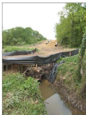
Figure 50 Gaines métalliques recouvertes d'un platelage en rondins de bois (photo : TEREGA)
