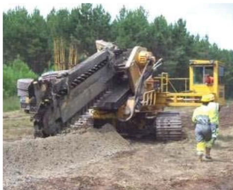
Figure 163 : Intervention d'une trancheuse pour la mise en place d'un drain temporaire le long de la tranchée
