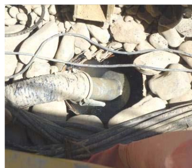
Figure 171 : Exemple de pompe enfouie dans les graviers en fond de fouille ou posée dans une structure métallique entourée de galets afin de diminuer le pompage de MES à la source
