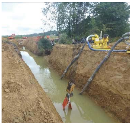
Figure 170 : Pompage dans la tranchée avec crépine surélevée
