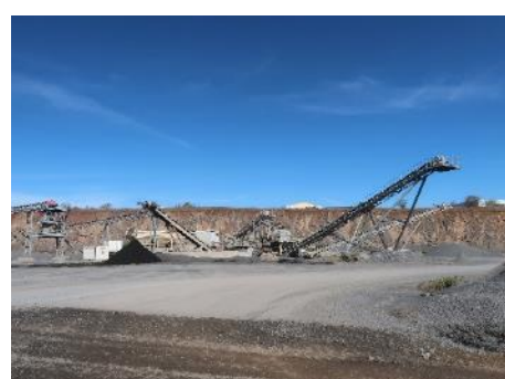
Site de traitement présent au Sud-Est du site d'étude Source : ARTIFEX 2021
