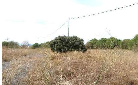
Ligne aérienne basse tension au droit du site d'étude
