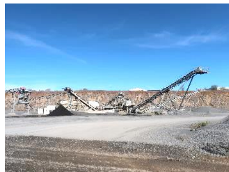
Site de traitement, anciennement la carrière de « Naffrie » Source : ARTIFEX 2021
