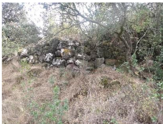
Muret de soutènement
