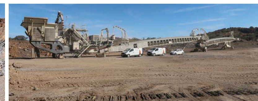
Installation primaire et convoyeur à bande sur la carrière de « La Vière »
