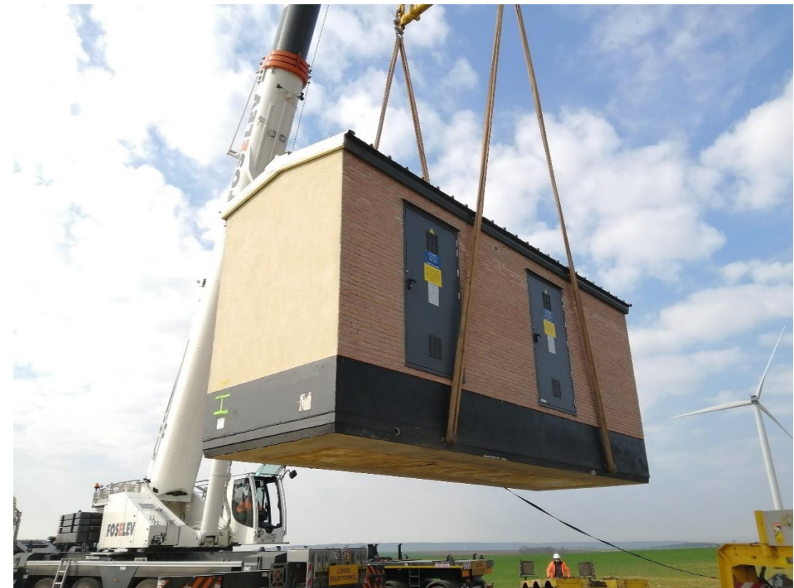
Figure 86 : Pose d'un poste de livraison (source : NEFS)
