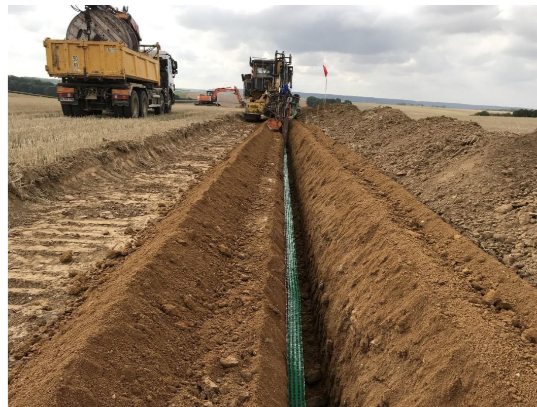
Figure 85 : Travaux de raccordement interne (source : NEFS)
