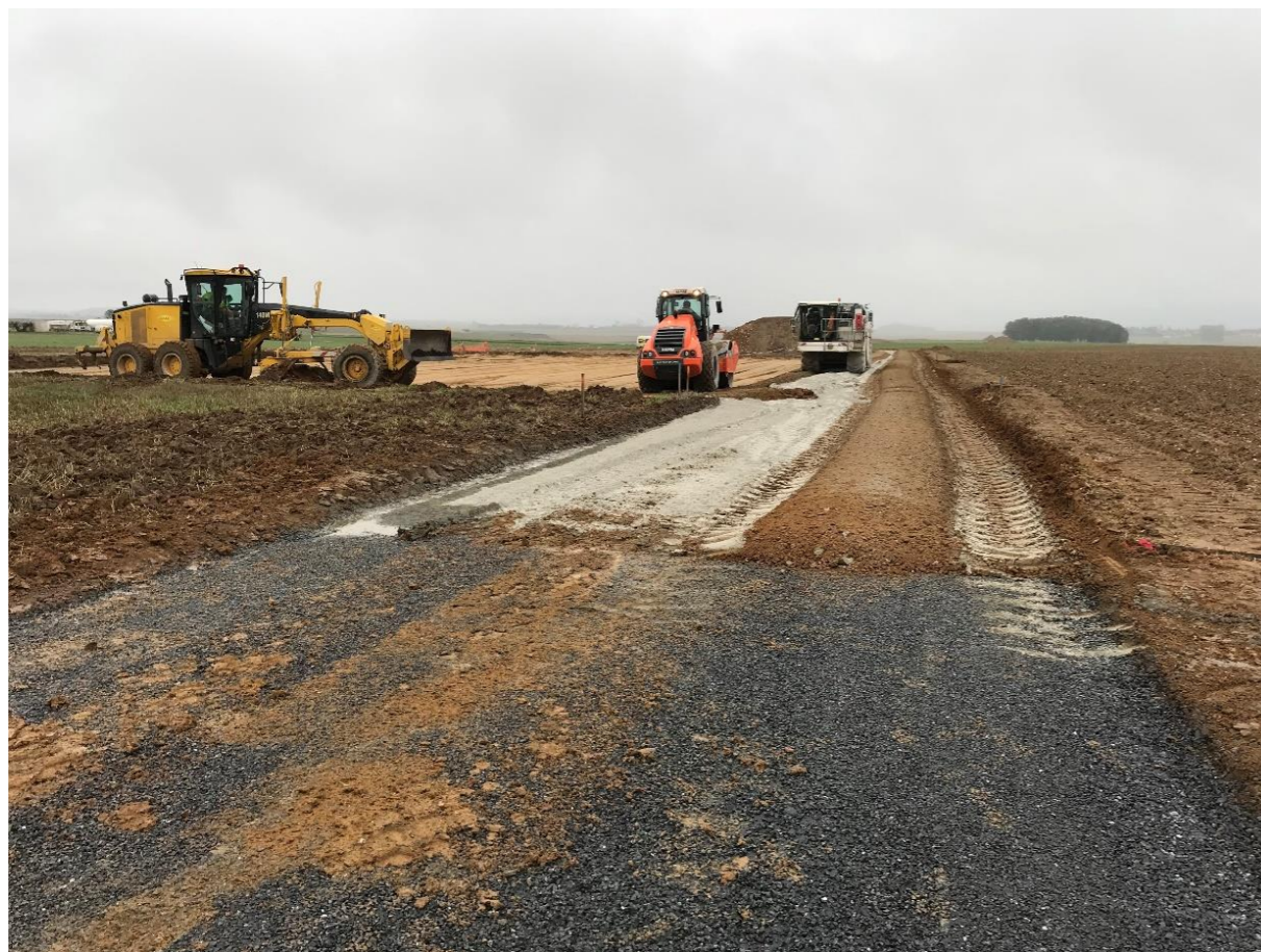
Figure 84 : Création de voie d'accès (source : NEFS)
