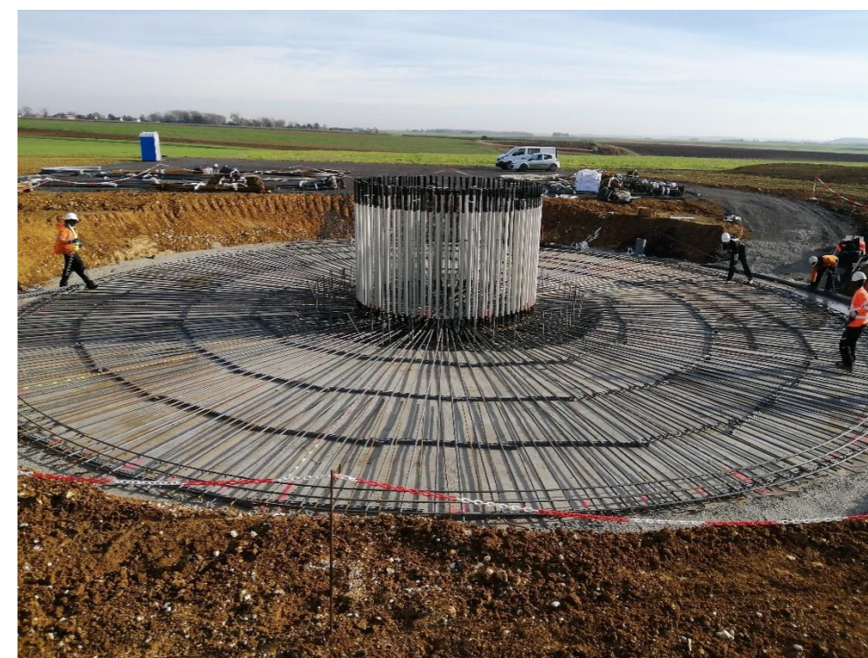
Figure 89 : Ferrailage d'une fondation (source : NEFS)
