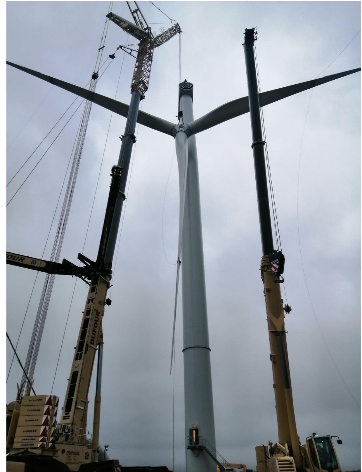
Figure 93 : Montage et assemblage des pales (NEFS)
