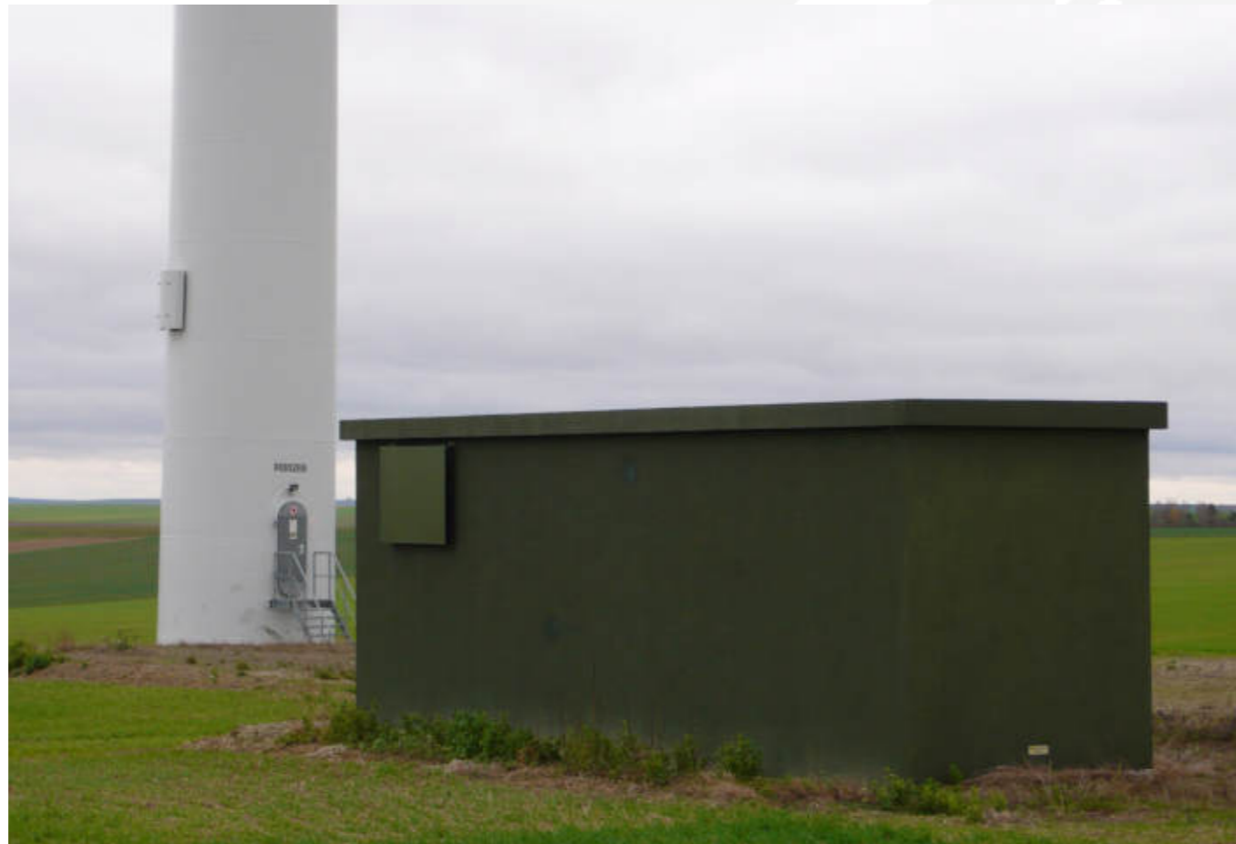
Exemple de poste de livraison présentant une couleur adaptée au contexte paysager et agricole
