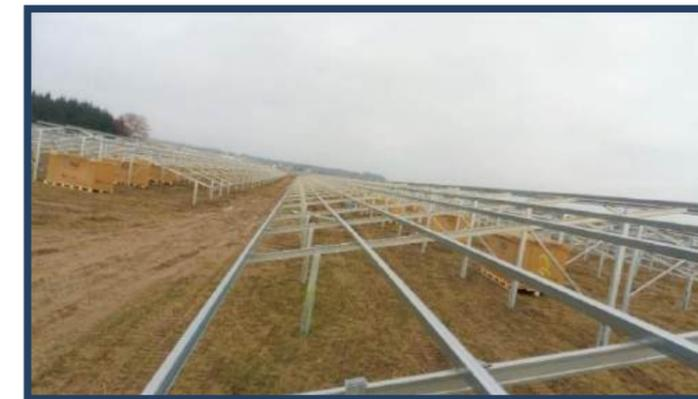
Figure 49 : Exemple structure fixe et système de fixation pour installation photovoltaïque au sol
