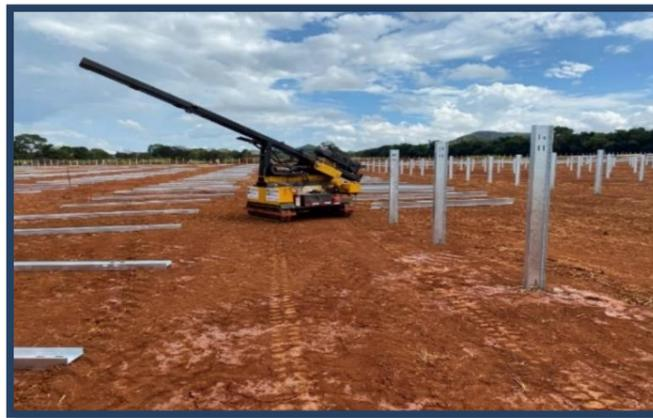
**Au vu des caractéristiques du sol du site d'Arthon, la solution de pieux battus semble la plus appropriée sur la plus grande partie du site et permet de limiter de manière conséquente les mouvements de terre.**
