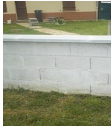
MUR DE CLOTURE NON ENDUIT
