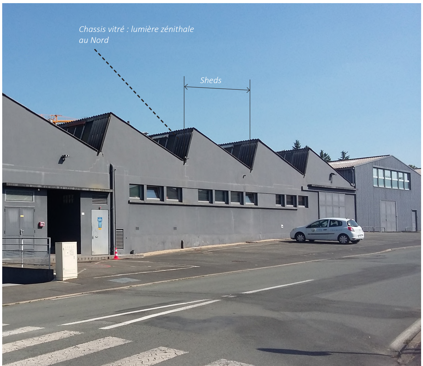
Entrepôt, La Gaubretière
