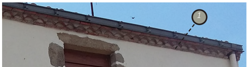
Génoise simple sur une maison de ville, Tiffauges
