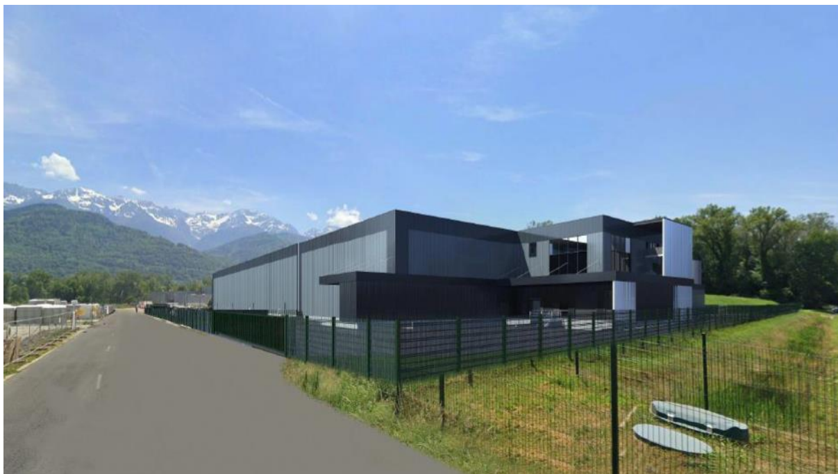
FIGURE 152 : VUE DE L'EXTENSION 1510 CÔTÉ NORD DU SITE (SOURCE : PAC DE FÉVRIER 2024)
