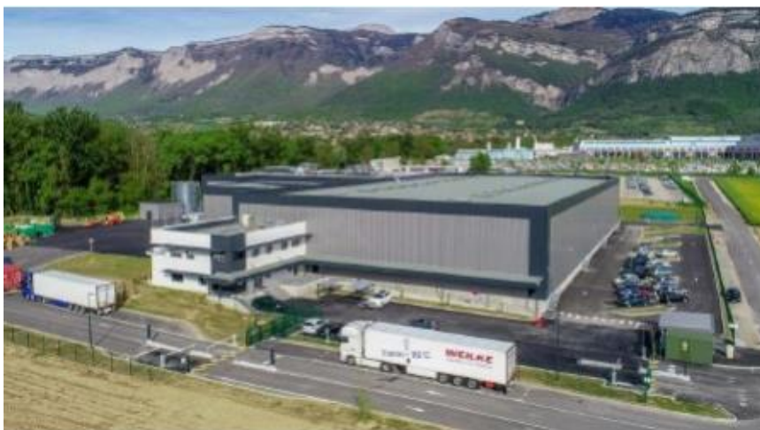
FIGURE 172 : VUE GÉNÉRALE SUR LE SITE ECTRA (SOURCE : ÉTUDE D'IMPACT)
