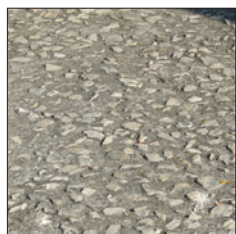
PIERRES JOINTÉES À LA CHAUX
