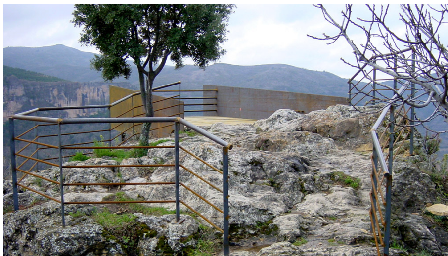
Garde corps aux teintes neutres, intégré au site - EMF architectures paysages
