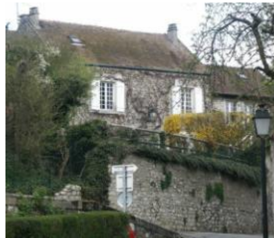
Les calcaires et meulières du substrat rocheux ont été utilisés dans l'architecture.
