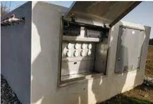
Exemple de muret technique électricité
