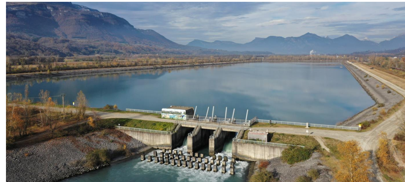
Figure 1 : Vue de la partie sud du bassin du Cheylas, au niveau de l'ouvrage de restitution (source : Améten, 2019)
