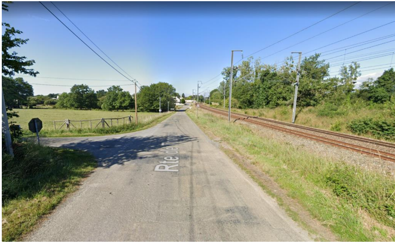
FIGURE 282 : PHOTOGRAPHIE 1 - INTERSECTION ROUTE DE THORIGNY ET LA TOUCHE AURY (SOURCE : GOOGLE MAPS)
