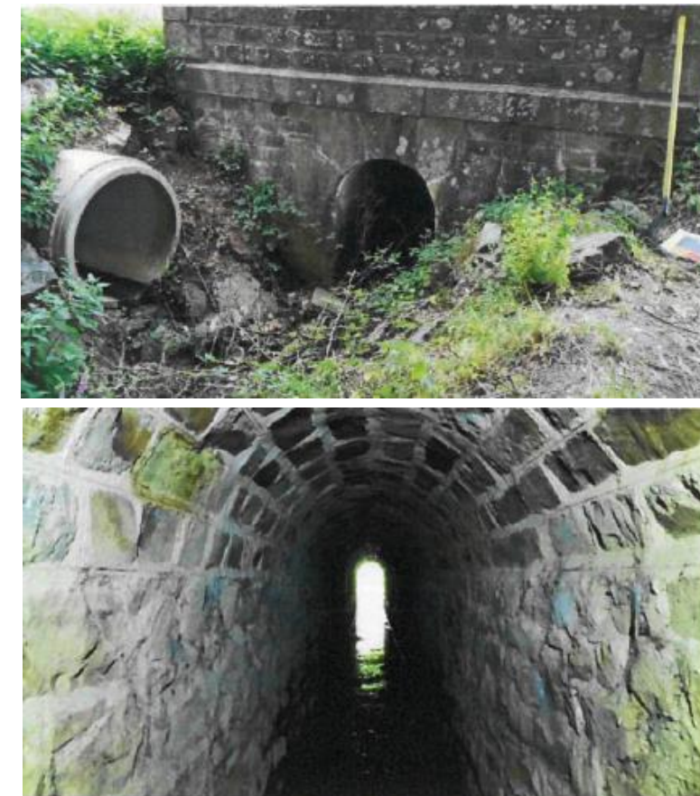
FIGURE 345 : L'AQUEDUC MAÇONNE EN PLACE SOUS LES VOIES SNCF
