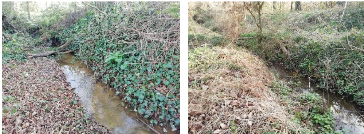
FIGURE 138 : LE COURS D'EAU DANS LE BOISEMENT LOCALISE ENTRE LA VOIE FERREE ET LA ROUTE DE BETTON (PARTIE NORD DE L'AIRES D'ETUDE IMMEDIATE) (SOURCE : EGIS, FEVRIER ET MAI 2022)
