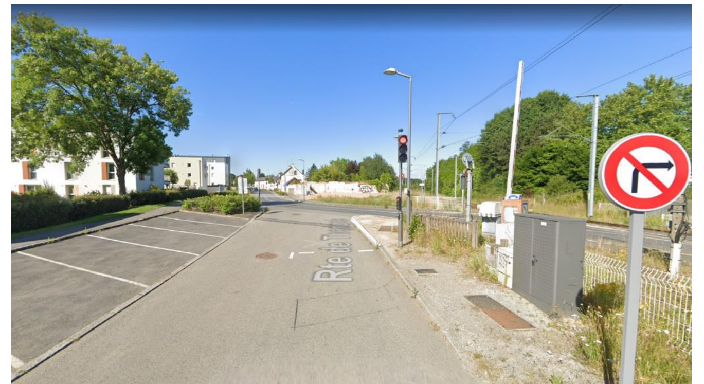
FIGURE 285 : PHOTOGRAPHIE 4 - PASSAGE A NIVEAU N°4 AU NIVEAU DE L'INTERSECTION DE LA ROUTE DE THORIGNY ET DE LA VOIE DE LA LIBERTE AU SUD (SOURCE : GOOGLE MAPS)
