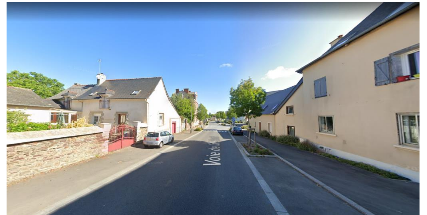
FIGURE 289 : PHOTOGRAPHIE 8 - VOIE DE LA LIBERTE AU SEIN DE MAISON-BLANCHE, AVANT L'INTERSECTION AVEC LA RUE DES FREGATES (SOURCE : GOOGLE MAPS)
