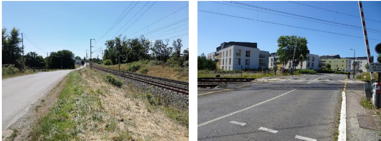
FIGURE 154 : LA VOIE FERREE ET LE PASSAGE A NIVEAU PN4 (SOURCE : EGIS, JUIN ET JUILLET 2022)
