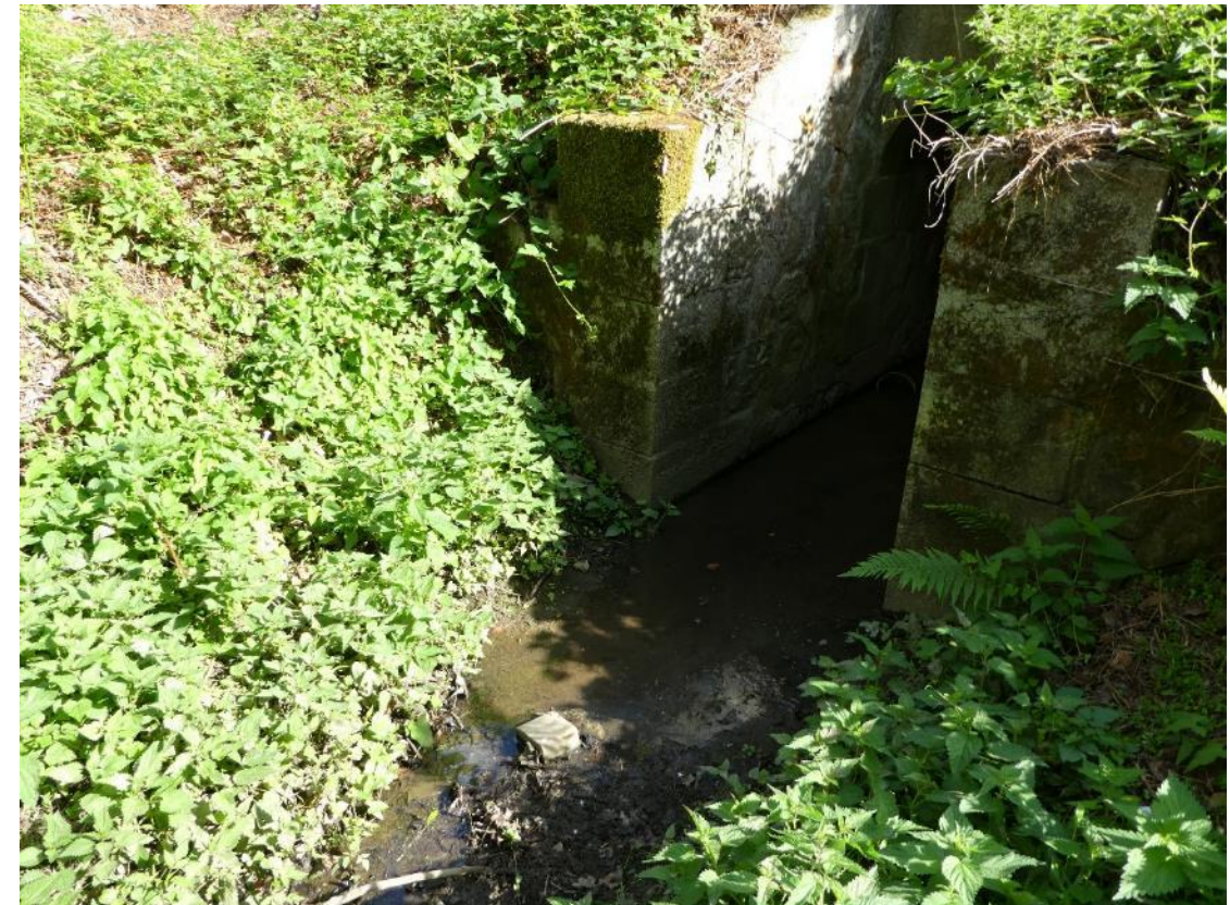
FIGURE 218 : LE COURS D'EAU TRAVERSANT LA ZONE D'ETUDE RAPPROCHEE ET SON OUVRAGE DE FRANCHISSEMENT AU NORD DE LA VOIE FERREE (SOURCE : EGIS, 2022)
