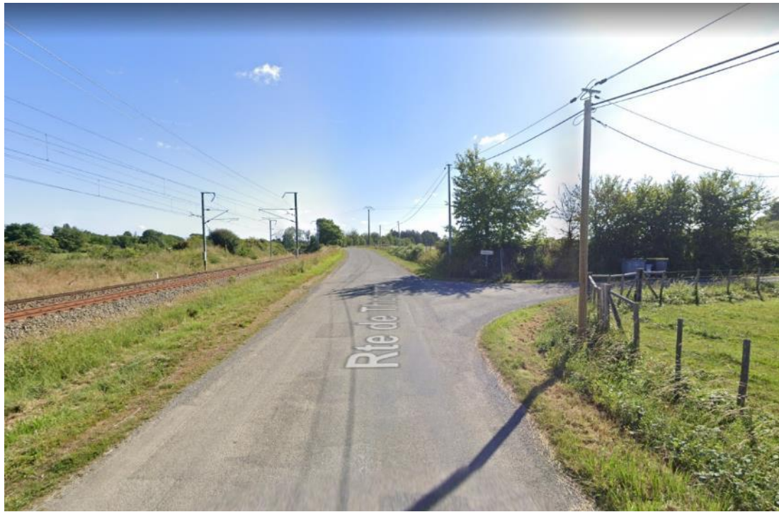
FIGURE 234 : PHOTOGRAPHIE DE LA ROUTE DE THORIGNÉ QUI LONGE LA VOIE FERRÉE ET LA TOUCHE AURY À DROITE DANS LE SENS EST-OUEST (SOURCE : GOOGLE MAPS, JUIN 2022)
