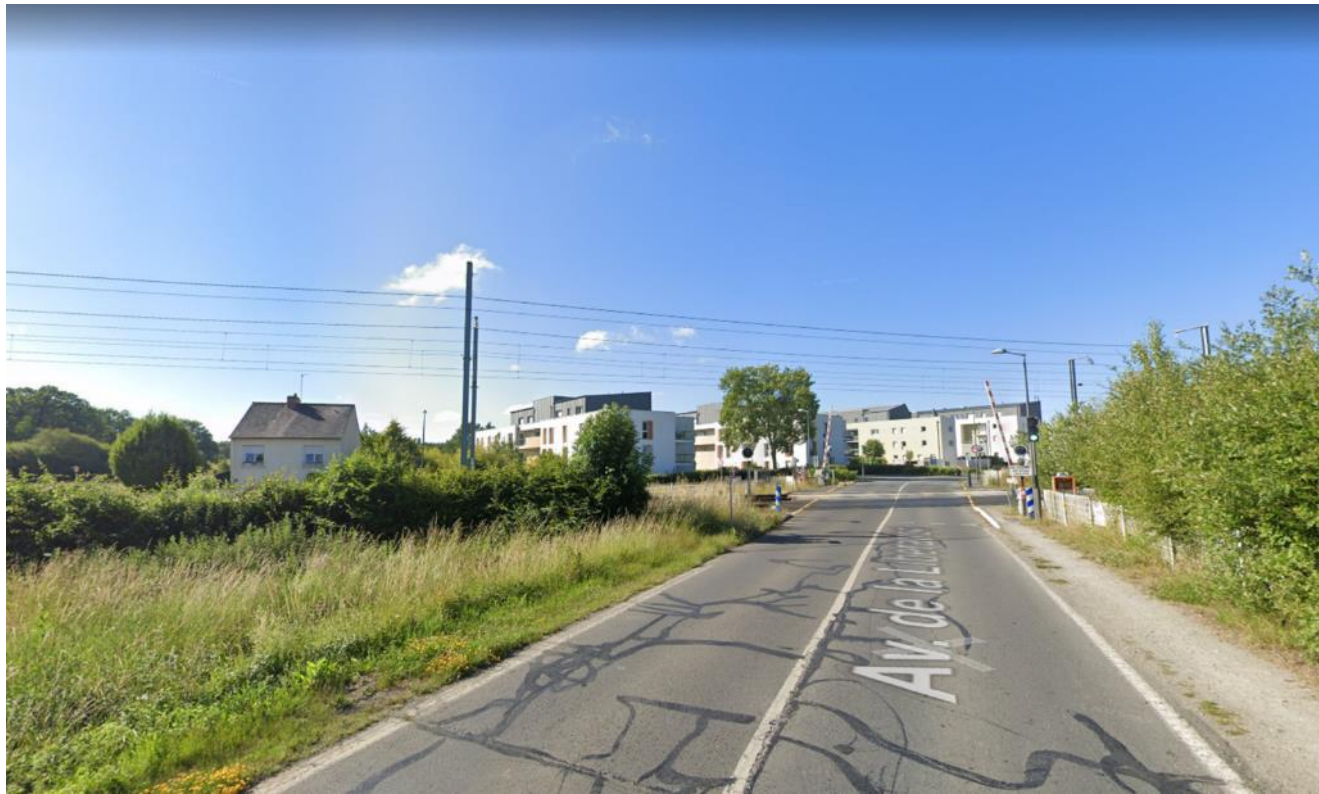
FIGURE 286 : PHOTOGRAPHIE 5 - PASSAGE A NIVEAU N°4 VOIE DE LA LIBERTE (SOURCE : GOOGLE MAPS)
